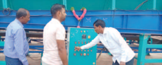
డంపింగ్ యార్డులో బయో మైనింగ్ వనులను ప్రారంభిస్తున్న కమీషనర్ మల్లారెడ్డి
